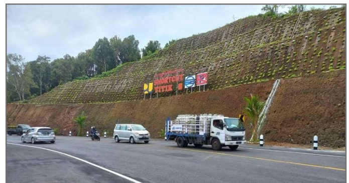
Figure 01 : The Singaraja-Mengwitasi Shortcut Project
