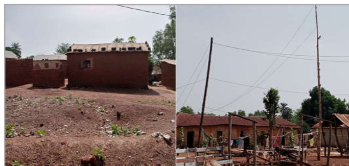
Photo 1 : Habitat traditionnel à Ouaké Photo 2 : Habitation traditionnelle à Kassoua Allah
